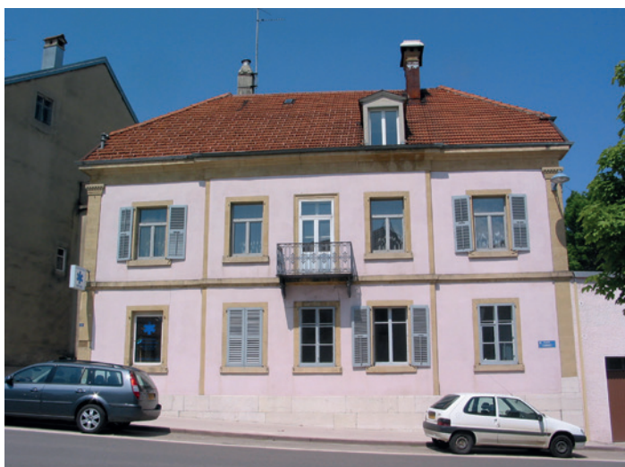
Ci-dessus, le soubassement en pierre marque l'assise du bâtiment et sa jonction avec la rue. La teinte de la façade reste sobre et bien intégrée.
