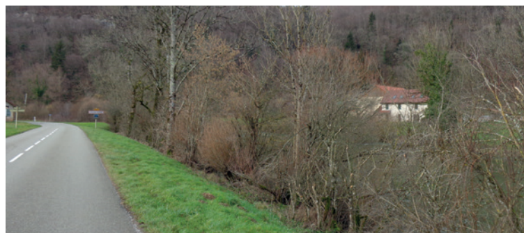
La ripisylve participe au maintien des berges, et permet d'éviter un affaissement du talus en cas de crue et donc de préserver l'intégrité de la chaussée.
