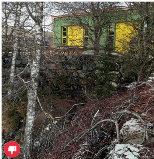
On constate souvent la cohabitation malheureuse d'espaces construits et de gouffres, amenant ces derniers à être « sécurisés » par la création déqualifiante, voire dangereuse, d'ouvrages maçonnés tels que des soutènements en béton.
