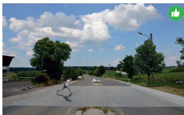
Exemple de l'entrée de ville « Nord » du Russey : un revêtement différent permet de matérialiser les traversées de la voirie et le partage apaisé de la chaussée.
