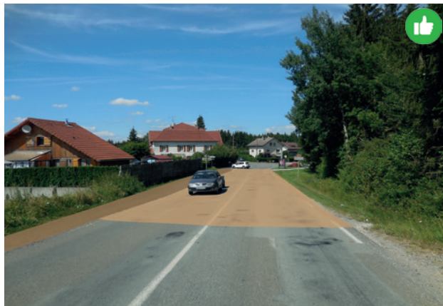
Exemple de l'entrée de ville « Sud » de Maïche : le marquage au sol par des matériaux et des coloris spécifiques permettraient d'appuyer l'impression de pénétrer dans un espace urbanisé.
